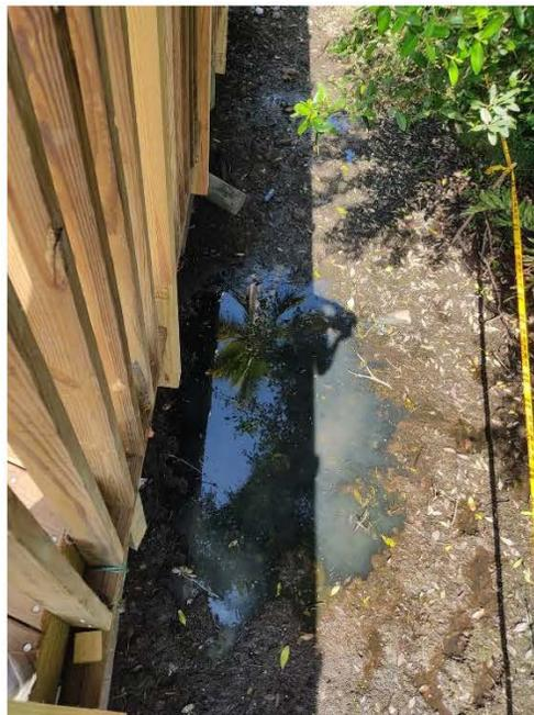
*Foto 3. ARD estancadas debajo de los senderos de madera de la UF1 del Ecoparque Mallorcaín, debido a los reboses en el canal receptor de las descargas de la EBAR Mallorcaín.*
