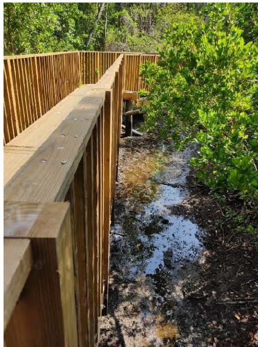
*Foto 5. ARD estancadas debajo de los senderos de madera de la UF1 del Ecoparque Mallorquín, debido a los reboses en el canal receptor de las descargas de la EBAR Mallorquín.*
